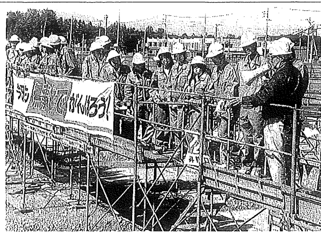
工事概要の説明を受け、建物の基礎などを見た
