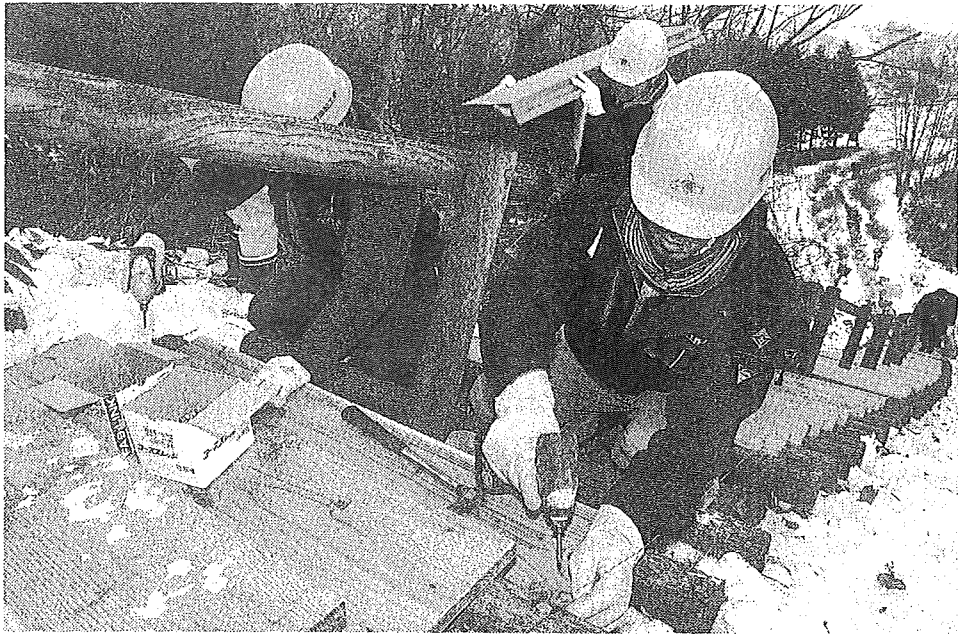
人力で運び上げた踏み板を、階段に設置する社員ら
