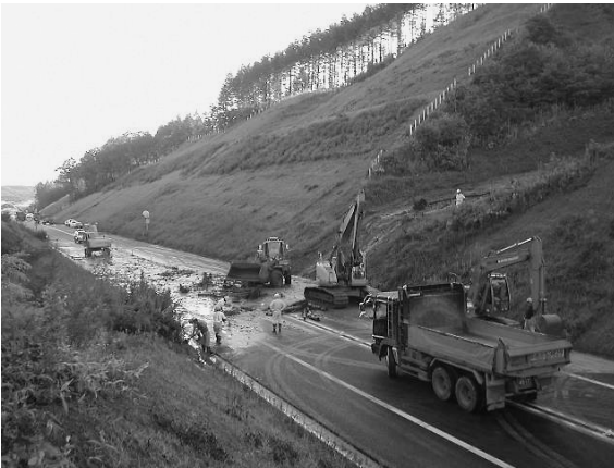
▶ 台風災害による東日本高速道路復旧作業
