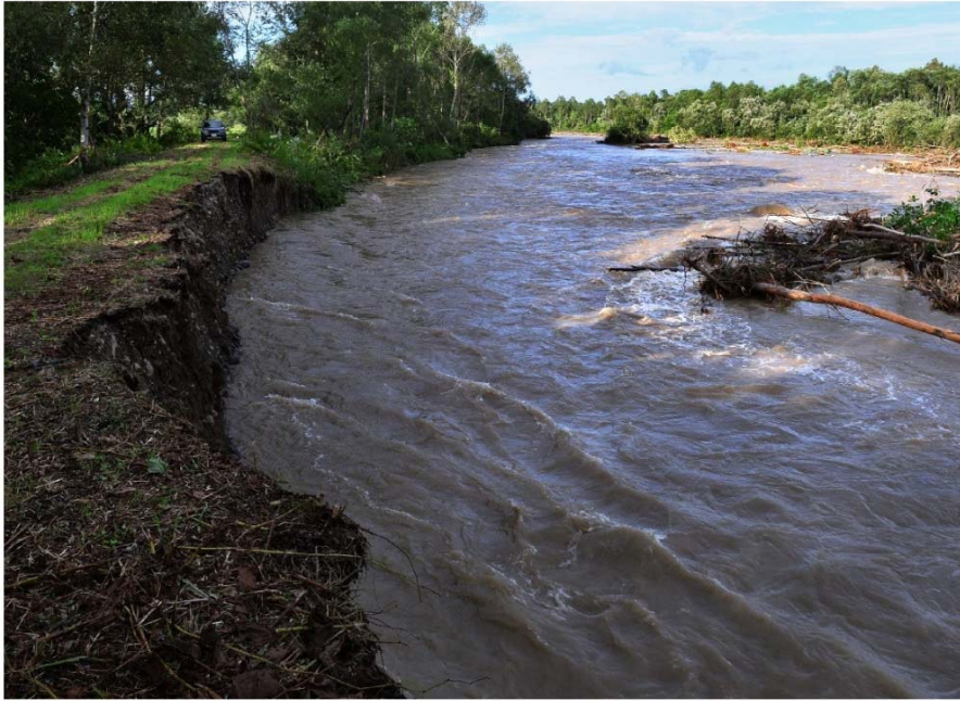
増水で崩れた音更川の堤防（23日、上士幌町上音更。塩原真撮影）
