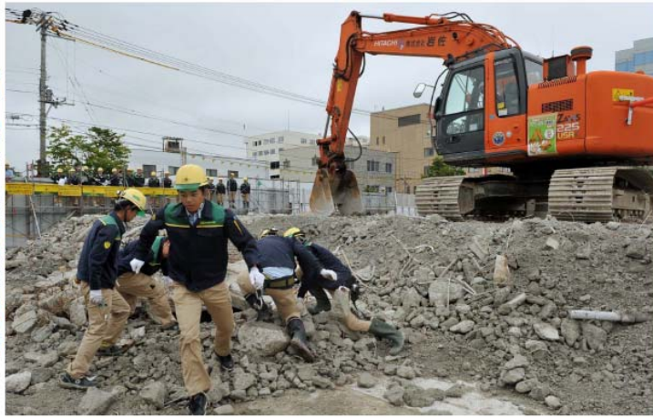
がれきの下敷きになった作業員の救出訓練に臨む宮坂建設の社員ら（28日午前11時10分ごろ、金野和彦撮影）
