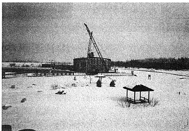
写真-1 防寒養生用の仮囲い (ADM工法採用)
